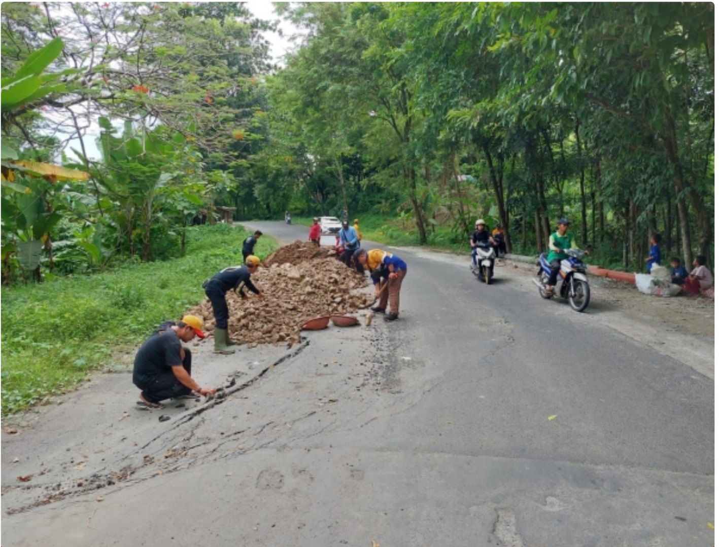
Polres Sukabumi Inisiasi Perbaiki Jalan Yang Rusak Dengan Instansi Terkait Jelang Nataru
