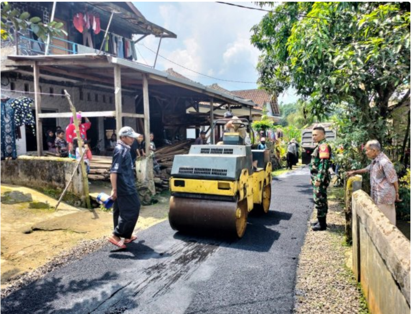
Serda Suherlan Giat Monitoring Perbaikan Jalan di Bojonglongok Kecamatan Parakansalak
